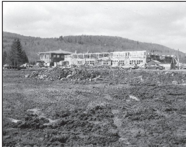
Vue du manoir du Lac-Delage en construction, vers 1964. Photographie : collection privée.
