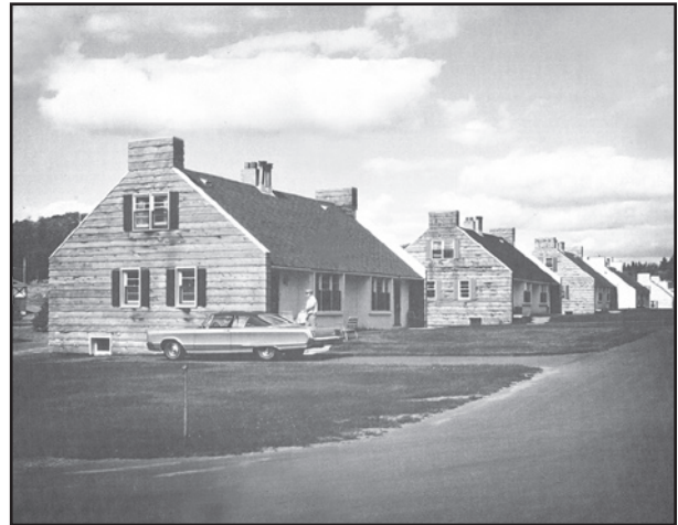
Le secteur de l'avenue des Crans comporte plusieurs résidences bifamiliales d'inspiration néo-Nouvelle-France qui se reconnaissent à leurs faux murs coupe-feu percés de cheminées. Ces maisons ont été déménagées de Sainte-Foy à l'époque où le centre commercial Place-Laurier a été érigé par les promoteurs Demers, Nolin et Racine. Photographie : Ville de Lac-Delage.
