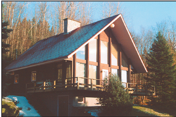
Fig. 15 : L'une des premières villas construites à Lac-Delage entre 1962 et 1964 selon les plans des architectes Walker & Tessier. Photographie : Sylvain Lizotte, 2003.
